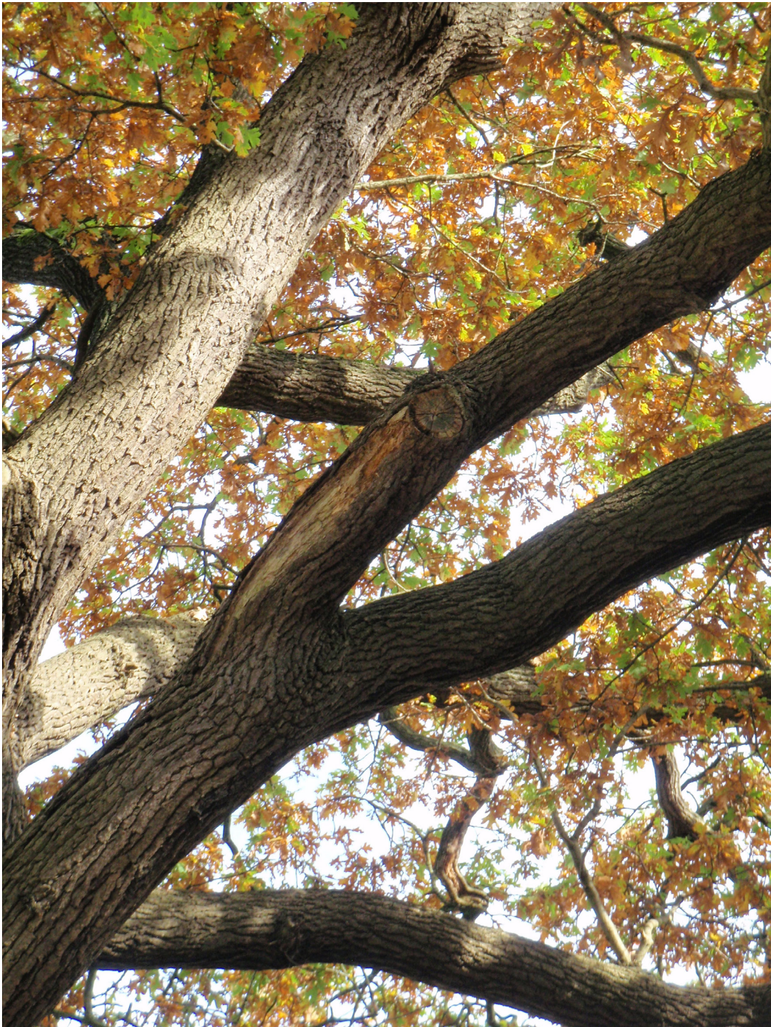
Beperkte rotting ter hoogte van een snoeiwond.
