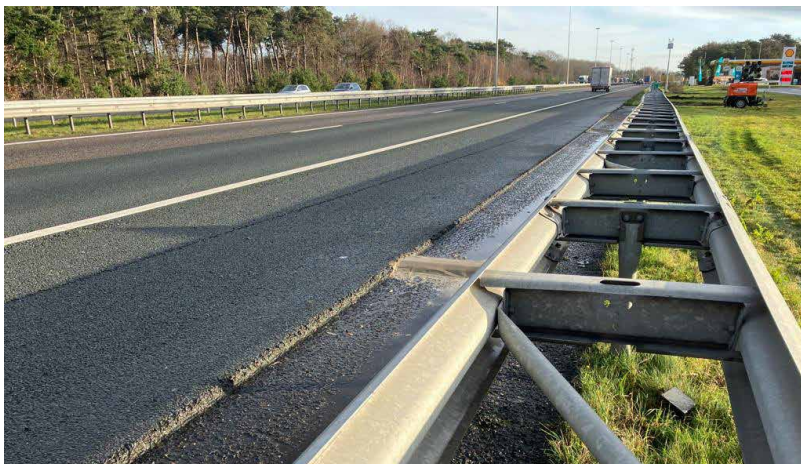
Goot langs de A58 waar het regenwater wordt verzameld naar de meetput wordt geleid (Foto: Rijkswaterstaat/InnovA58)
