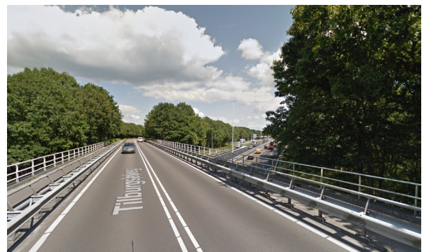
Viaduct Tilburgseweg in huidige situatie (foto: Google)
