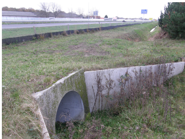
Kleine faunatunnel in de huidige situatie (foto: RWS)
