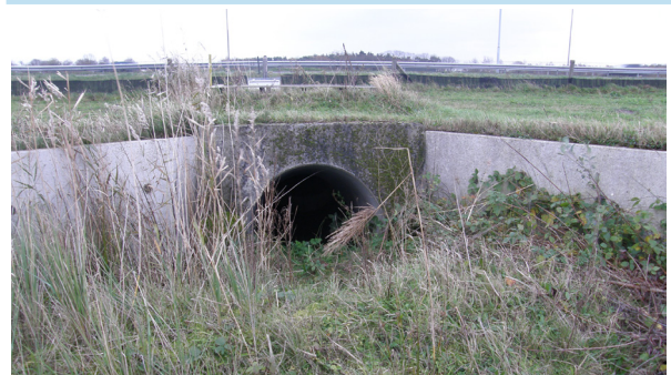
Kleine faunatunnel in de huidige situatie (foto: RWS)
