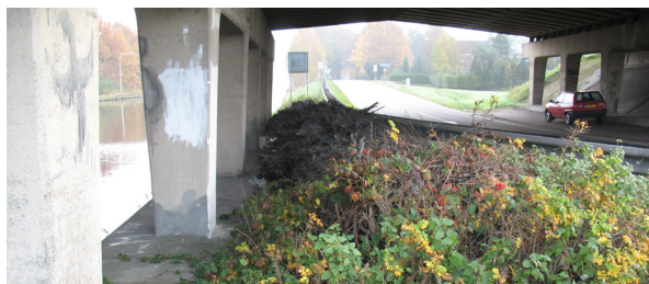
Ecologische passage Wilhelminakanaal in de huidige situatie (foto: RWS)
