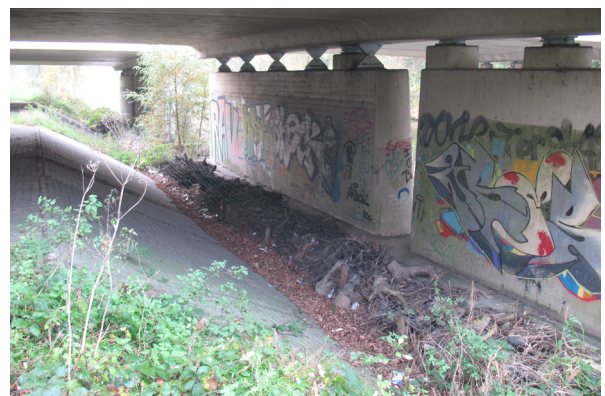
Ecologische passage Beatrixkanaal in de huidige situatie (foto: RWS)
