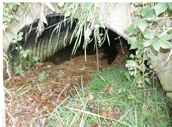
De Broekloop in de huidige situatie (foto: RWS)
