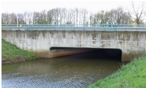
De Nieuwe Leij in de huidige situatie (foto: RWS)
