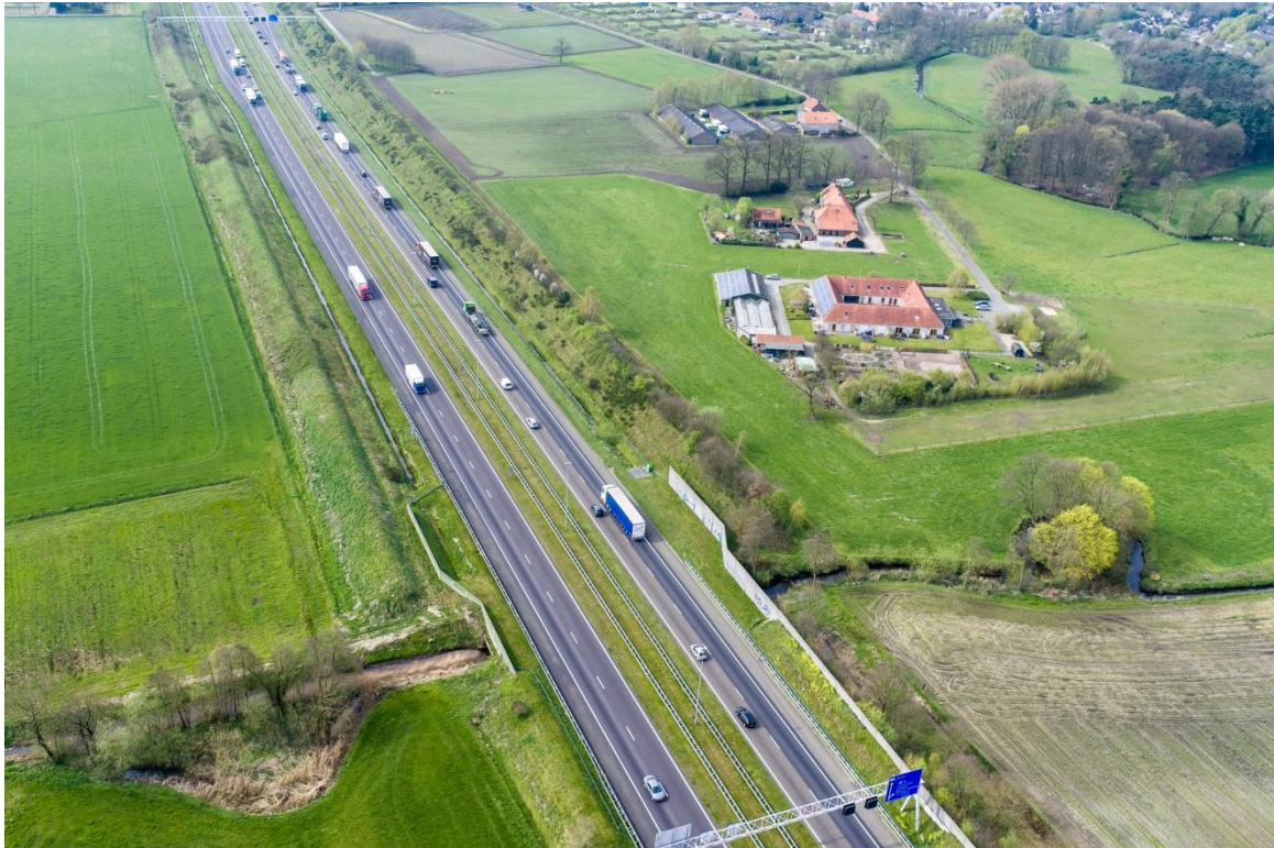
Afbeelding I.7 Kunstwerk Anneville naar aansluiting Ulvenhout
