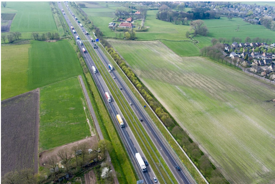
Afbeelding I.6 Kunstwerk Anneville naar aansluiting Ulvenhout
