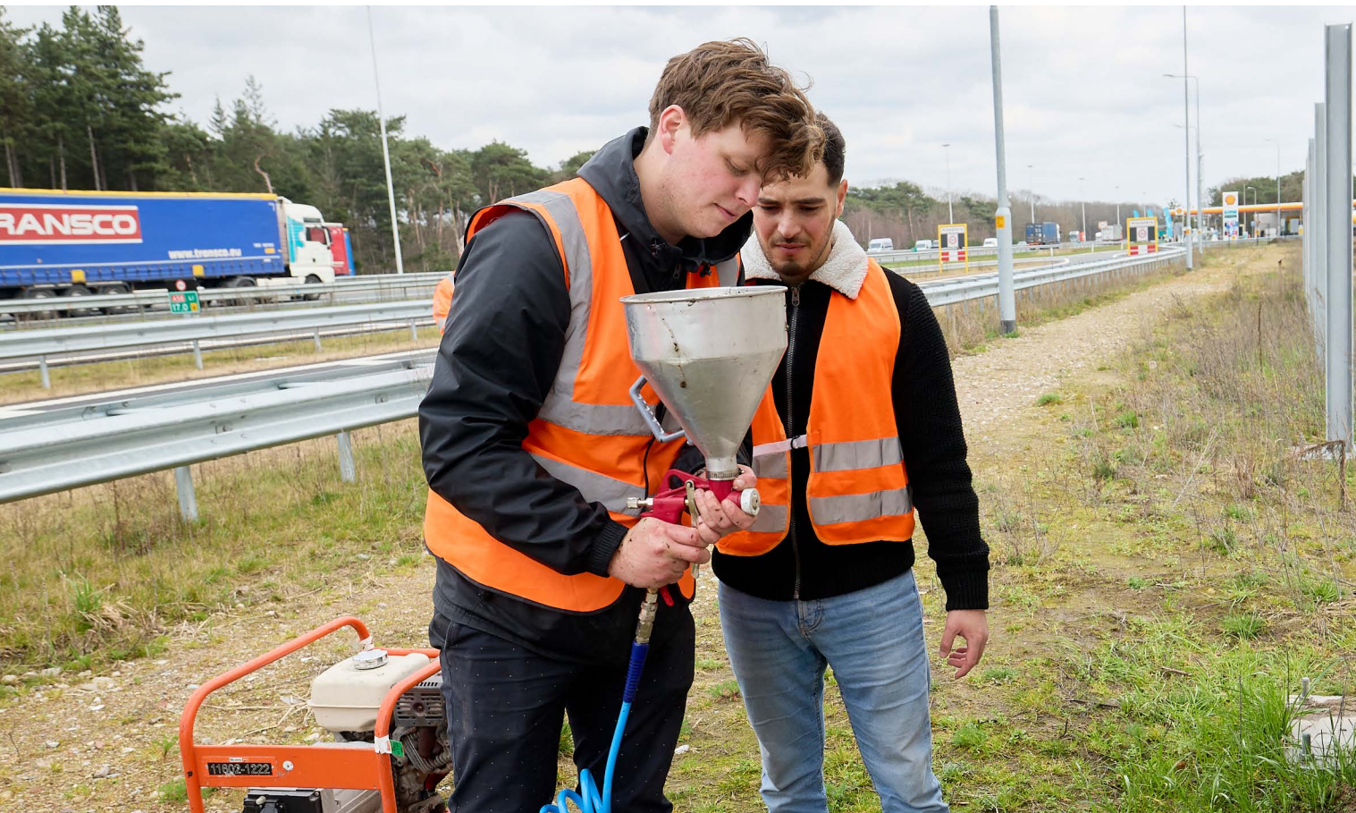
Aanbrengen van mengsel t.b.v. mosgroei, maart 2023
