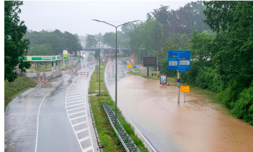
Overvloedig water op de snelweg
