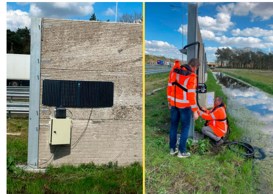
Aanbrengen irrigatiesysteem, maart 2024
