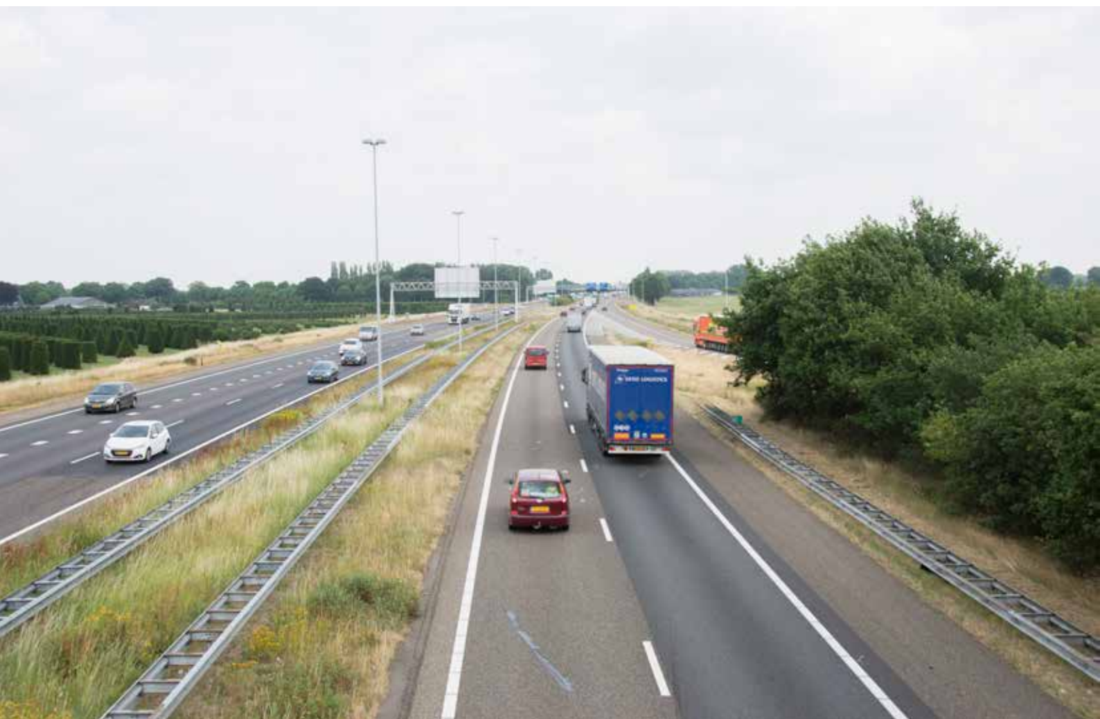
De A58 gezien vanaf de Gilzeweg, kijkend richting Tilburg
