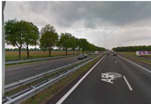
7 ter hoogte van viaduct Reedijk
