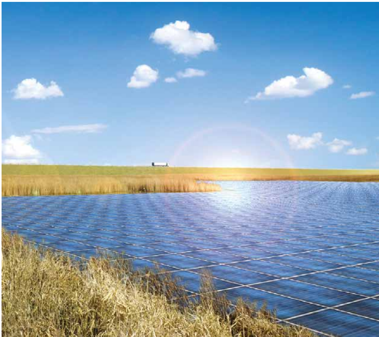
Energie-opwekking in grote, robuuste eenheden
